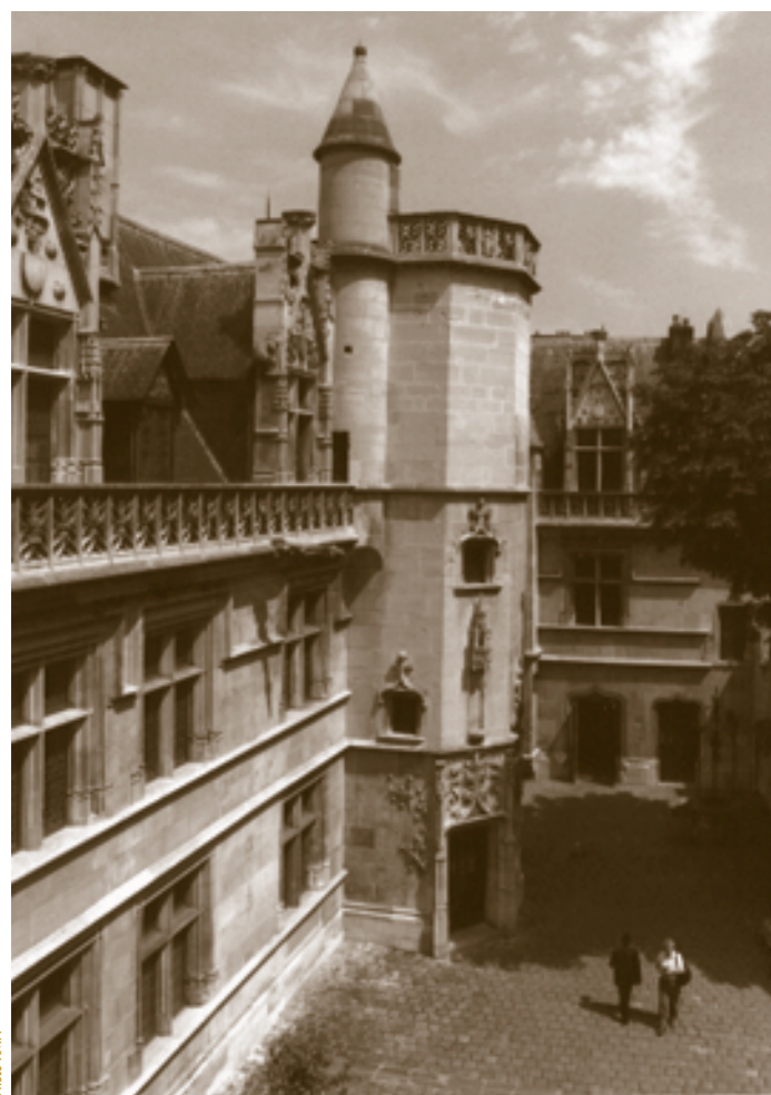
Les ailes nord et est de l'hôtel de Cluny, vues de la cour. Les travaux réorganisent le 2 e étage, celui des grandes lucarnes.
